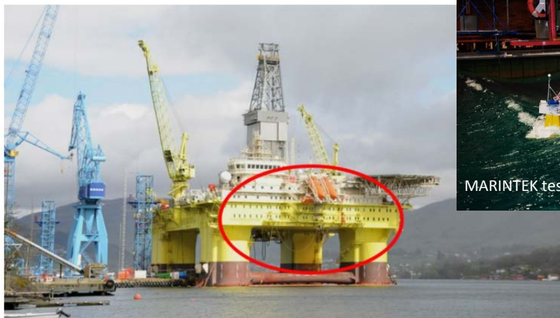
HER TRAFF BØLGEN: Boligkvarteret på riggen COSL Innovator ble truffet av bølgen som tok livet av en 53-år gammel arbeider. 17 lugarventiler ble slått inn av bølgen som skylte over riggen.
