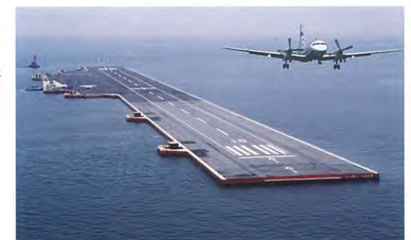
図5 メガフロート 写真:日本造船技術センター
