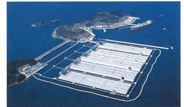
図2 上五島石油備蓄基地 提供:上五島石油備蓄株式会社
