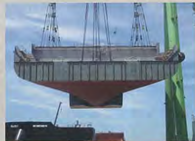
図12 クレーンで運ばれる搭載ブロック
